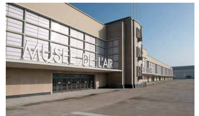
Façade est de l'aérogare
