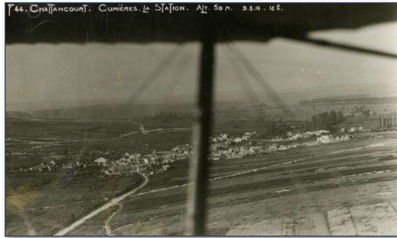
Photographie prise par l'escadrille F44 du village de Cumières le 9 août 1916 Photographie gélatino argentique
