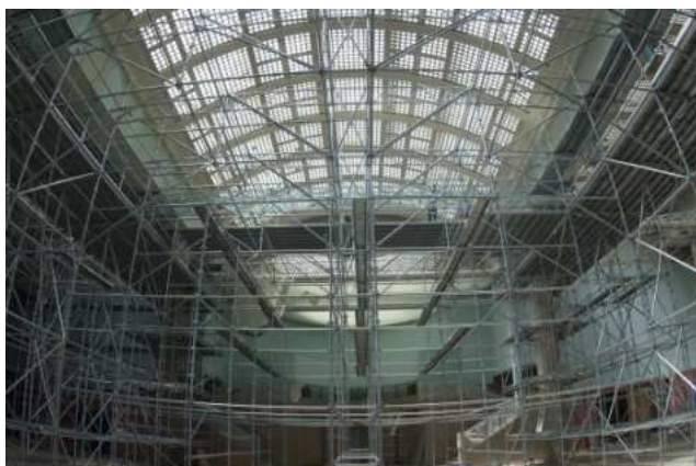
La Salle des Huit Colonnes en cours de rénovation, 2012
